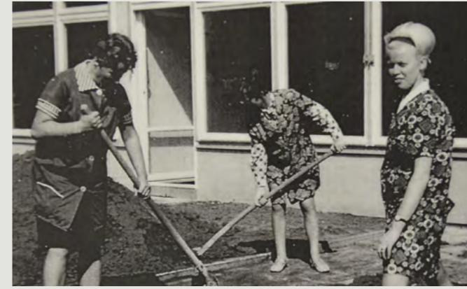
Aufbauarbeiten Kita Frieden
