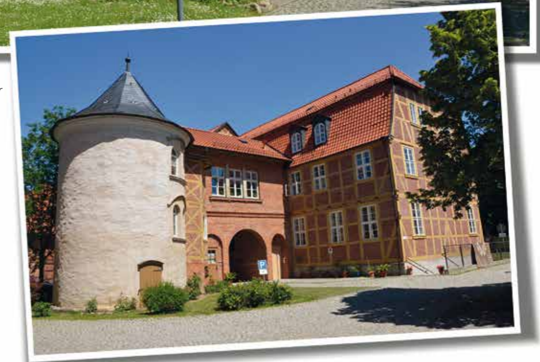
2016 wurden im Gästehaus zwei neue Seminarräume für Fortbildungen geschaffen. Foto: ESN
